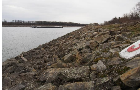
Typische Steine zur Befestigung des Flussufers
